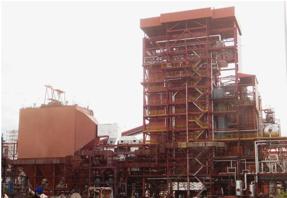
125 ATA, 540 ° C BAGASSE FIRED BOILER
